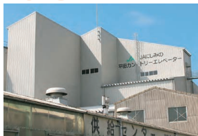
▲平田カントリーエレベーター
